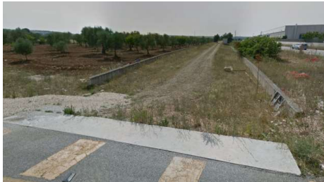
Opera di protezione condotta AQP lato compagna
